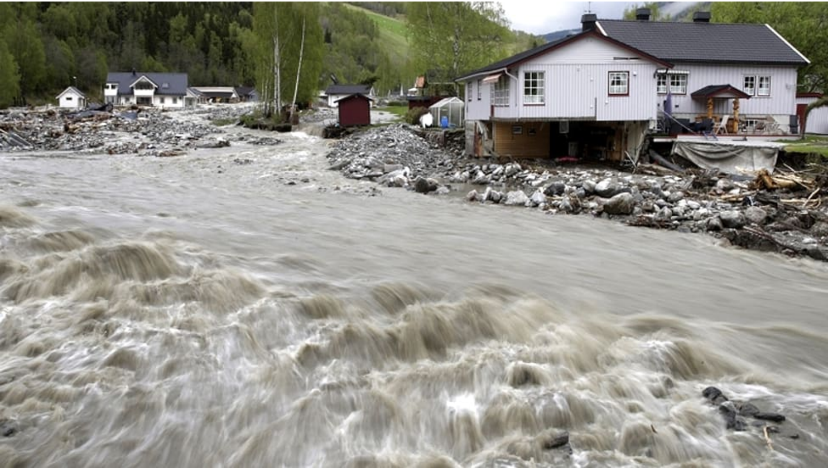
Flom og skader pga. flom i Kvam i Gudbrandsdalen i 2013
